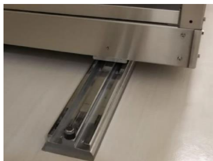
レール施工の一例（露出）
